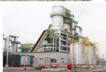
解体前(撮影日H25.5.16)
