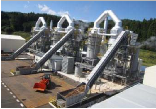
南三陸処理区仮設焼却炉 (本格稼働開始: H24.12)
