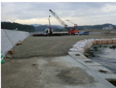
宮城県南三陸町の志津川漁港南防波堤復旧工事
