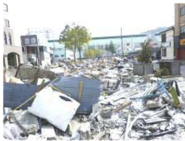
岩手県釜石市(平成23年4月撮影)
