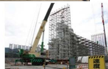
解体中(撮影日H25.9.26)
