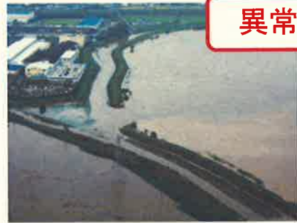
図： 洪水被害の事例 (写真提供：国土交通省中部地方整備局)
