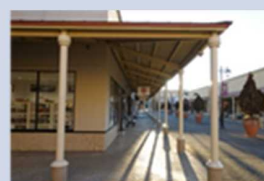
日除けによる日射遮蔽と雨除け
