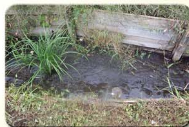
写真3 生息水路へ堆積した泥
