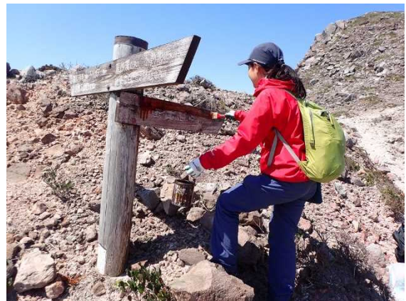
登山道看板の修繕（神津島）
