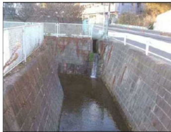
河川改修前の状況(平瀬川支川)
