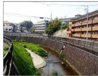
河川改修後の状況(平瀬川支川)
