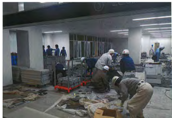
床材の撤去作業
