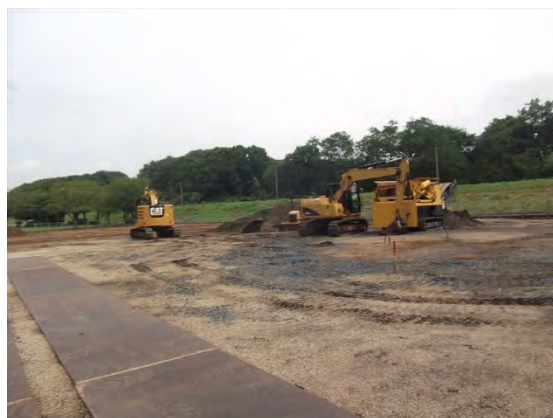
土砂の入れ替え工事 (宝堀球場)
