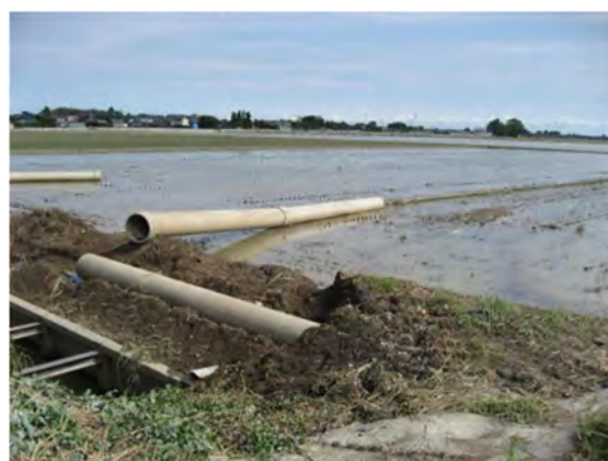
破損した送水管
