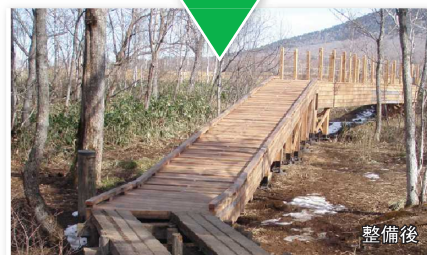
▲ 尾瀬国立公園(竜宮沼尻川橋整備)
