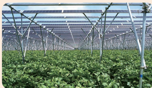
営農型太陽光発電設備 (千葉県匝瑳市)
