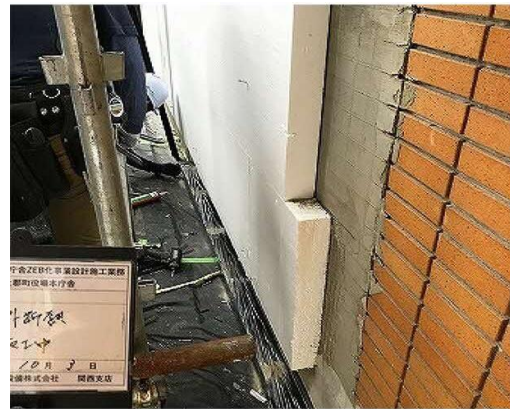
断熱材貼り付け（70mmポリスチレンフォーム）
