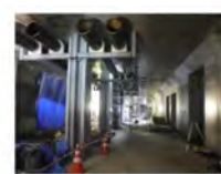
地下通路に敷設した熱導管ネットワーク
