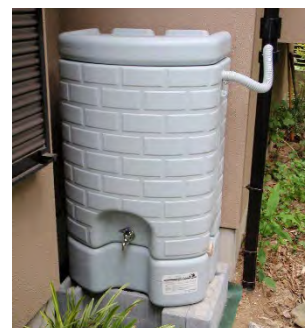
雨水貯留施設設置例 (千葉県佐倉市ウェブサイトより 135 )
