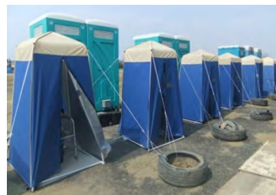
東日本大震災の際、宮城県東松島市の避難所に設置されたマンホールトイレ (国土交通省資料より 192 )
