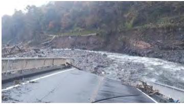
図 2.4 群馬県嬬恋村の土砂災害による落橋 （国土交通省関東地方整備局高崎河川 国道事務所ウェブサイトより 69）
