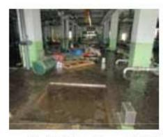
当施設での浸水は、処理棟と管理棟の1階部分で、最大で1.5 m にもなった。また、処理棟の地下ポンプ室とブロワ室は水没してしまい、し尿処理場としての機能は停止してしまった。7月17日午後より一部のし尿等の受け入れを開始したが、あくまで中継槽としての役割であり、全ての工程を行うまでの復旧は出来ず、他の施設に一部の処理を委託せざるを得ない状態での稼働となった。
