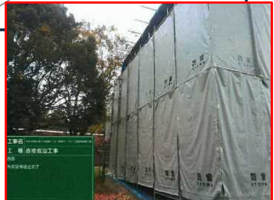
工事中は飼育B・Cケージに防音シートを設置
