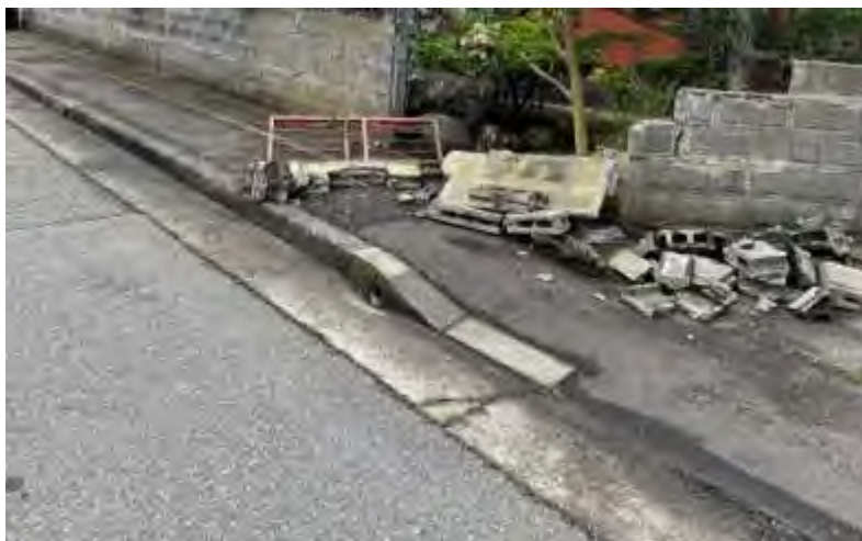
正院町 民家の塀の崩壊 環境省撮影（令和5年5月6日）
