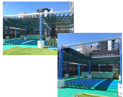
千代田区立保育園におけるフラクタル日よけ設置の様子 (関東地方環境事務所 撮影)
