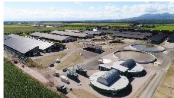
バイオガスプラント（北海道土幌町）
