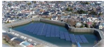
水上太陽光発電（埼玉県所沢市）
