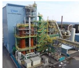
12m<sup>3</sup> 小規模試験高炉(水素還元)
