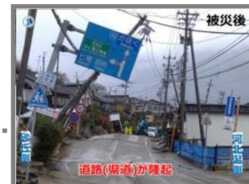
令和6年能登半島地震 液状化による地盤の流動
