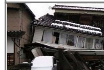
令和6年能登半島地震 木造建築物の倒壊
