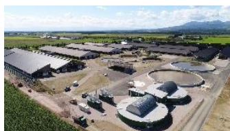
バイオガスプラント（北海道士幌町）
