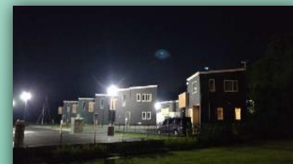
台風被害で停電したが、迅速に復旧した千葉県睦沢町
