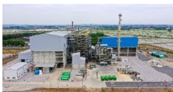
廃棄物発電（ベトナム）
