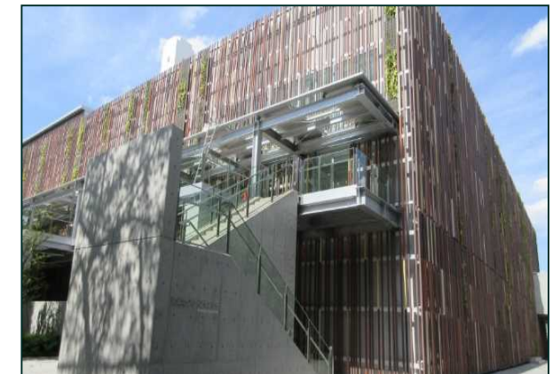
廃棄物焼却施設の外観
