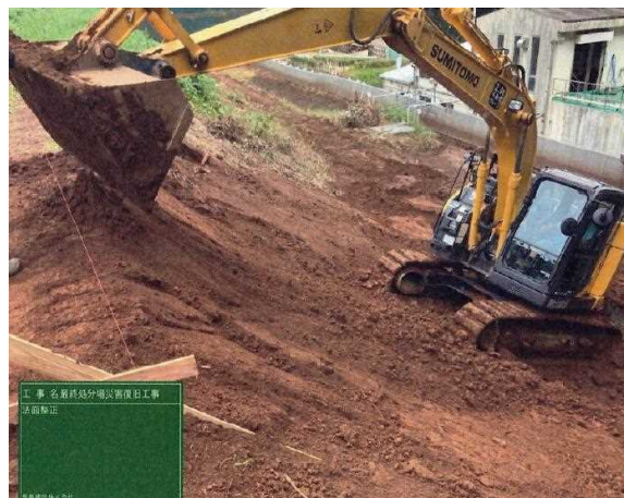
覆土・法面形成
