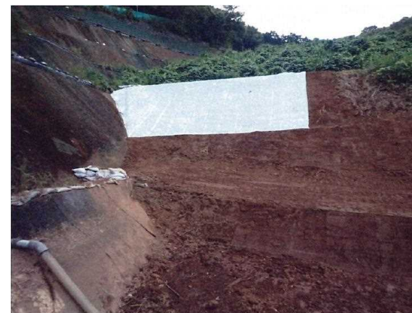
張芝(法面補強のための芝シート)
