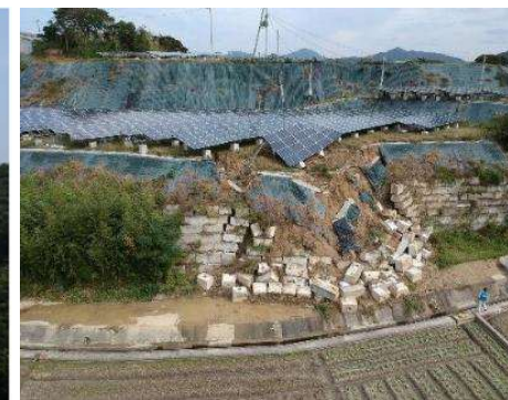
法面保護工が崩れて流出した事例
