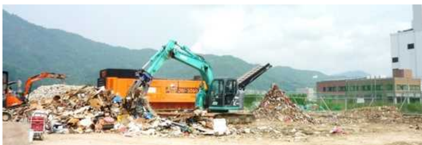
呉市広多賀谷多目的広場仮置場に設置した移動式破碎施設 撮影：廃棄物・3R 研究財団
