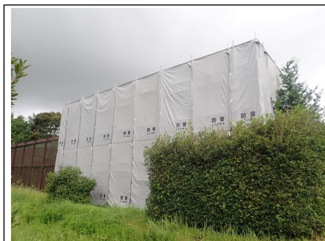
作業中の様子（防音シートによる遮蔽）
