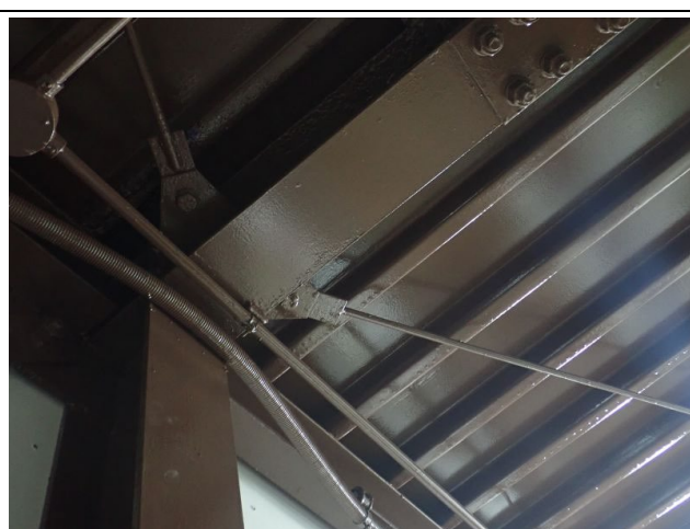
内部鉄骨等の再塗装状況
