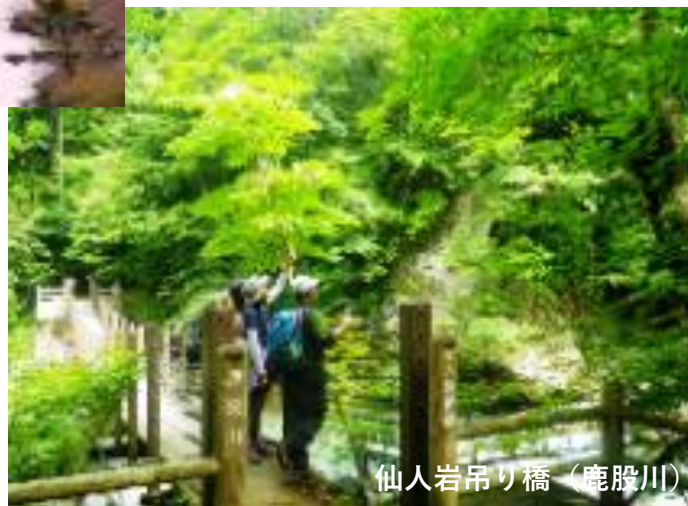
もみじ谷大吊り橋
