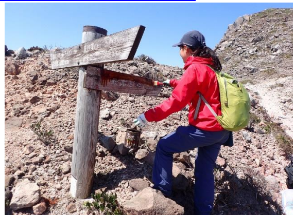
登山道看板の修繕（神津島）
