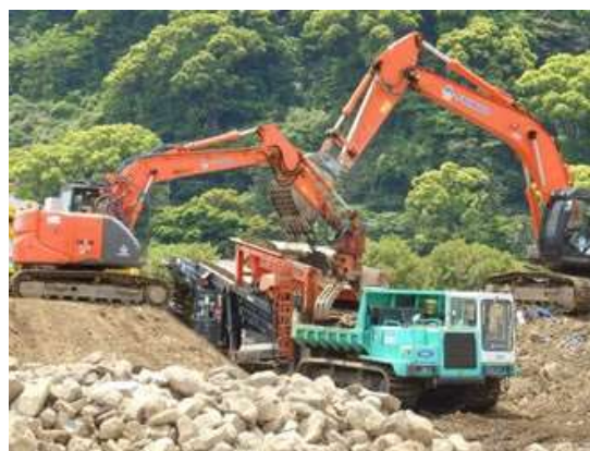
土砂篩い選別機による作業
