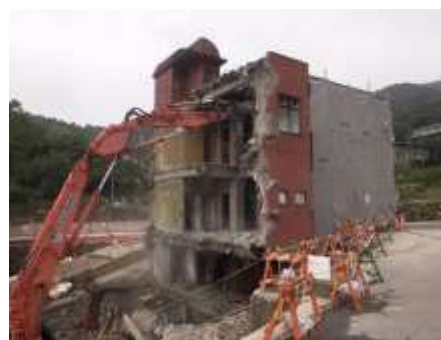
RC 家屋兼店舗解体
