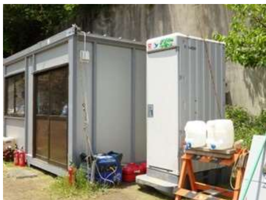
仮置場の現場詰所・仮設トイレ (令和4年5月10日) 写真撮影：廃棄物・3R 研究財団
