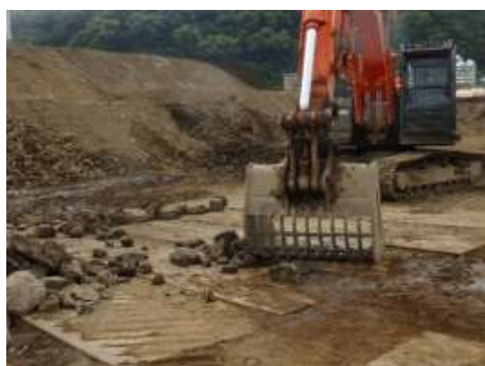
スケルトンバケットによる粗選別
