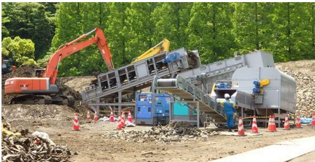
土砂選別作業では行方不明者の手掛かりになるものが含まれていないか 警察職員が確認作業を行っていた
