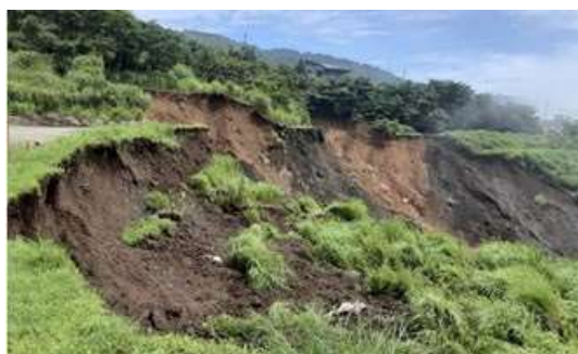
源頭部の被害状況
