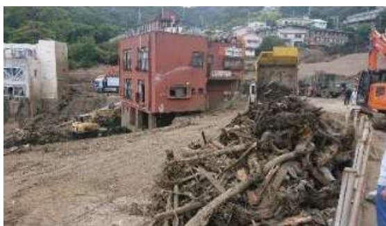
住宅地の被害状況
