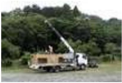
④ユニットハウス設置 （仮設トイレ、倉庫含）
