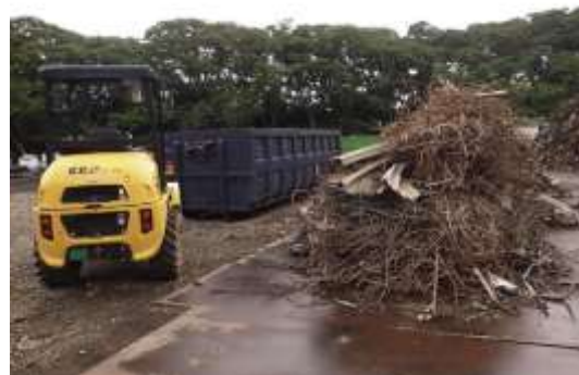
公費解体からの金属スクラップ
