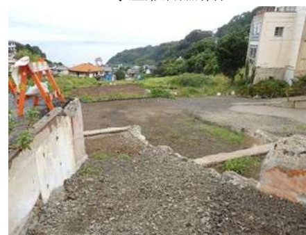
解体撤去跡地
