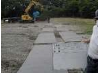
③敷鉄板搬入・布設
