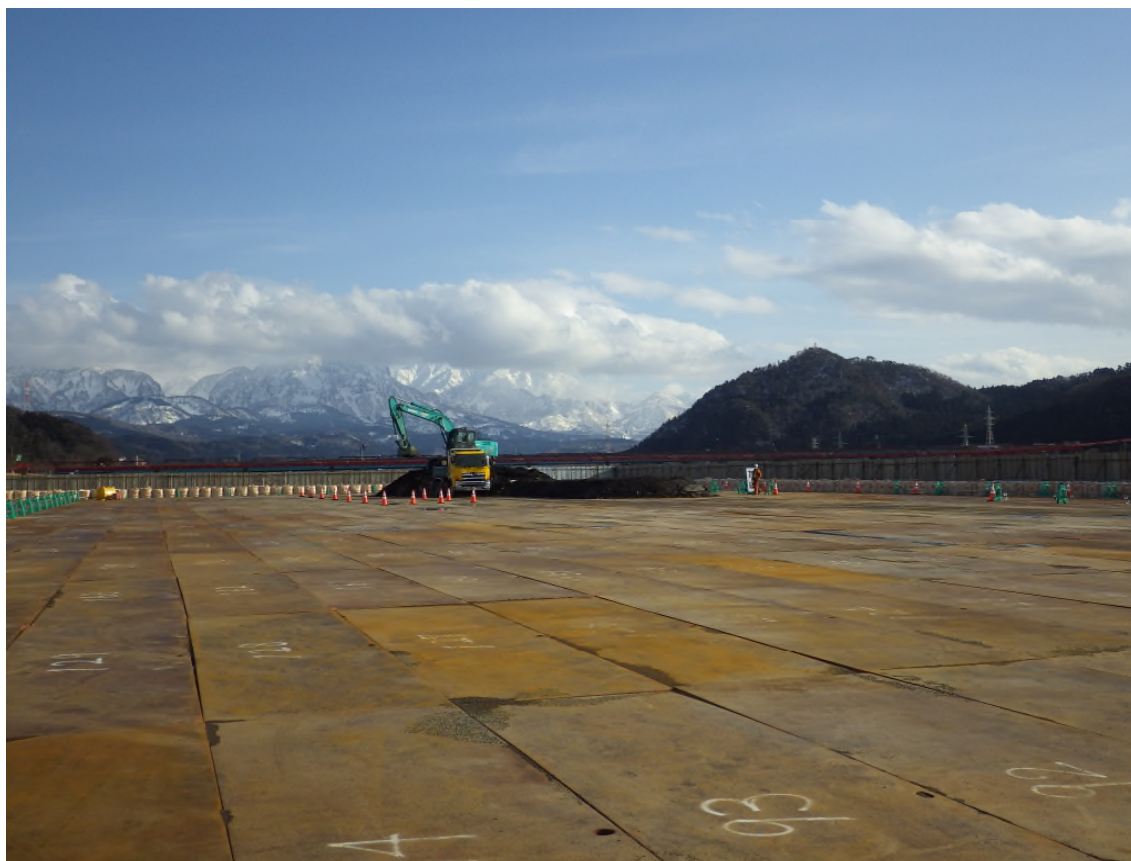
写真 2-2-(3)-5 敷鉄板の設置状況（開設後）
