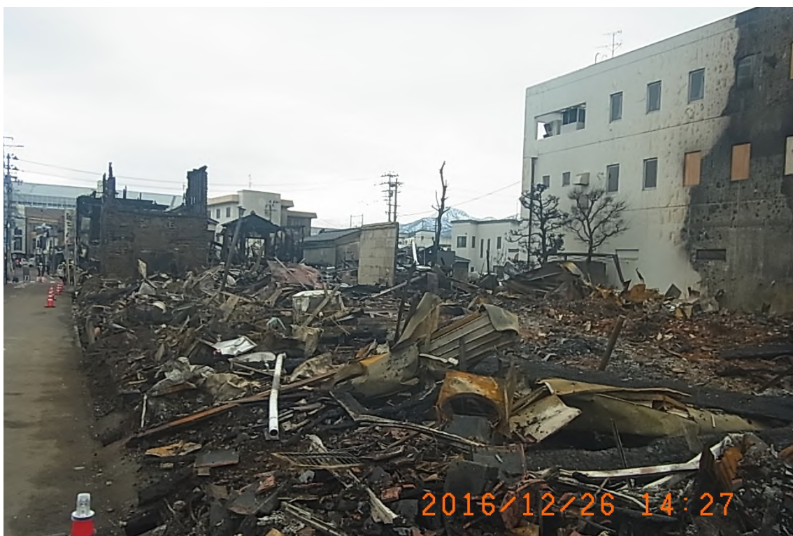
写真 1-1-(3)-4 4ブロックの被災状況
