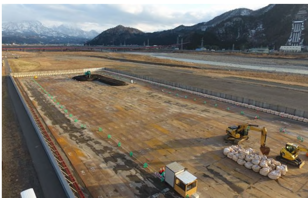
写真2-2-(3)-2 仮置場開設後の状況
