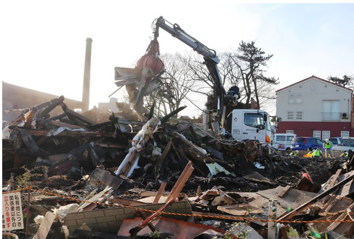
写真 2-2-(1)-1 金属くず撤去状況
