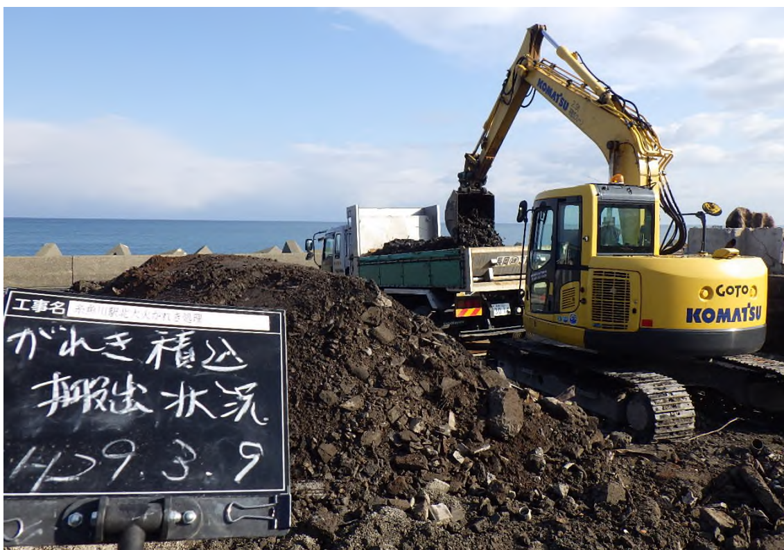
写真 2-3-(3)-1 燃え殻(混合残さ)の撤去状況
