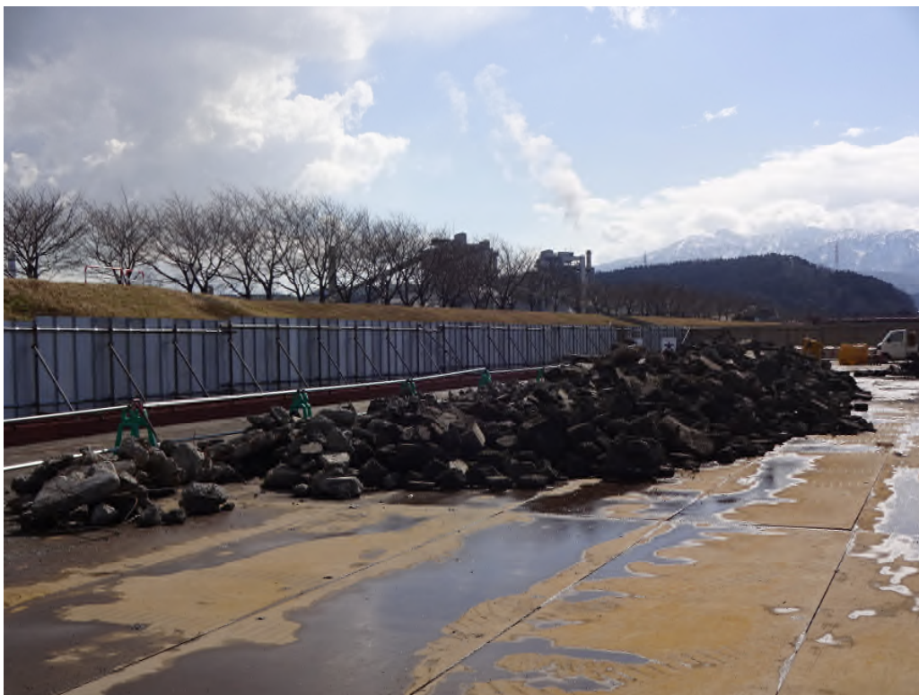
写真 2-3-(1)-5 コンクリートがら選別状況
