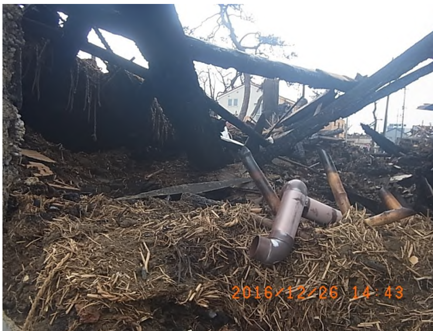
写真 4-2-(4)-1 土壁構造家屋の被災状況
