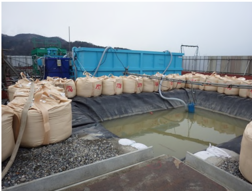
写真2-2-(3)-3 濁水処理施設及び仮設沈砂池等の設置状況（開設後）
