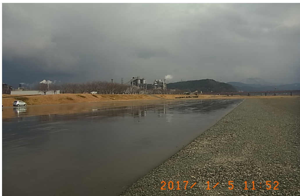
写真2-2-(3)-1 仮置場整備前の状況
