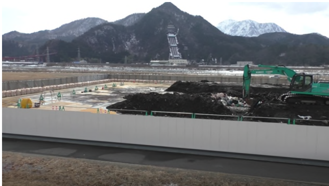
写真2-2-(3)-6 防風フェンスの設置状況（開設後）
