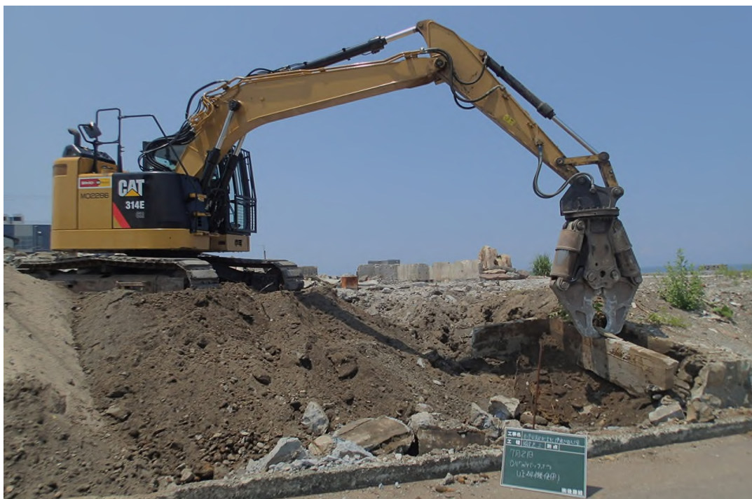
写真2-3-(5)-1 建物基礎の撤去状況
