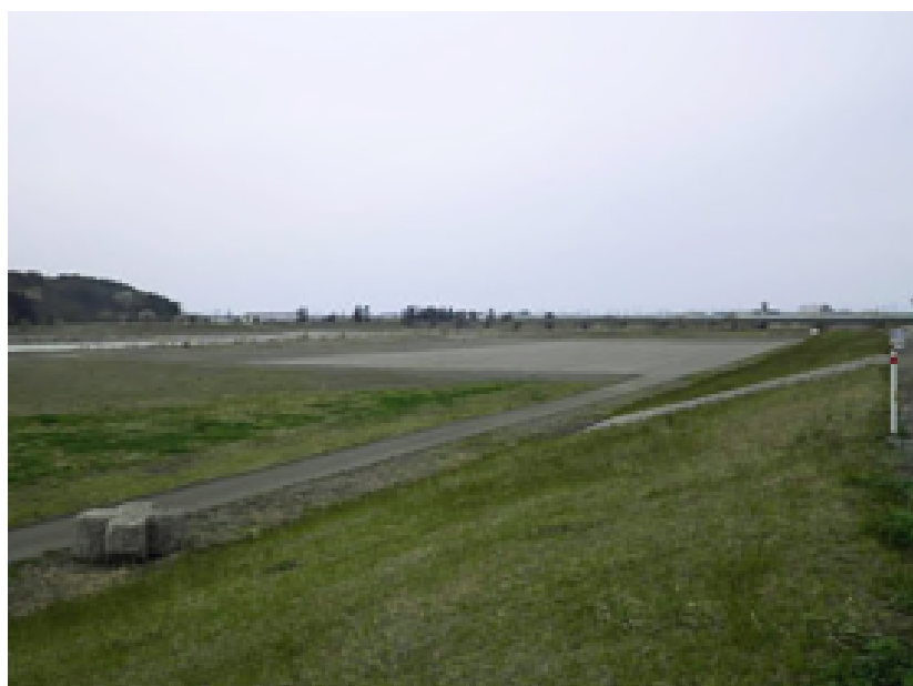
写真2-3-(4)-2 仮置場の原状復旧後
