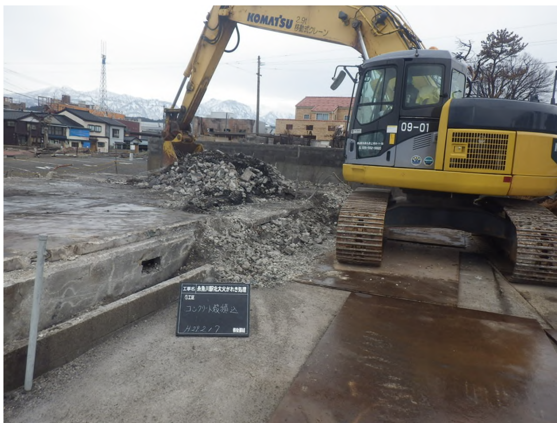
写真2-3-(2)-1 コンクリートがらの撤去状況
