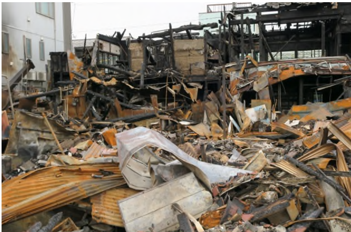
写真 4-1-(2)-1 金属くず及び木くず等の撤去前状況
