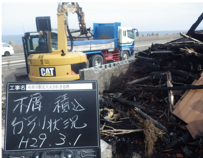
写真 2-2-(1)-2 木くず撤去状況
