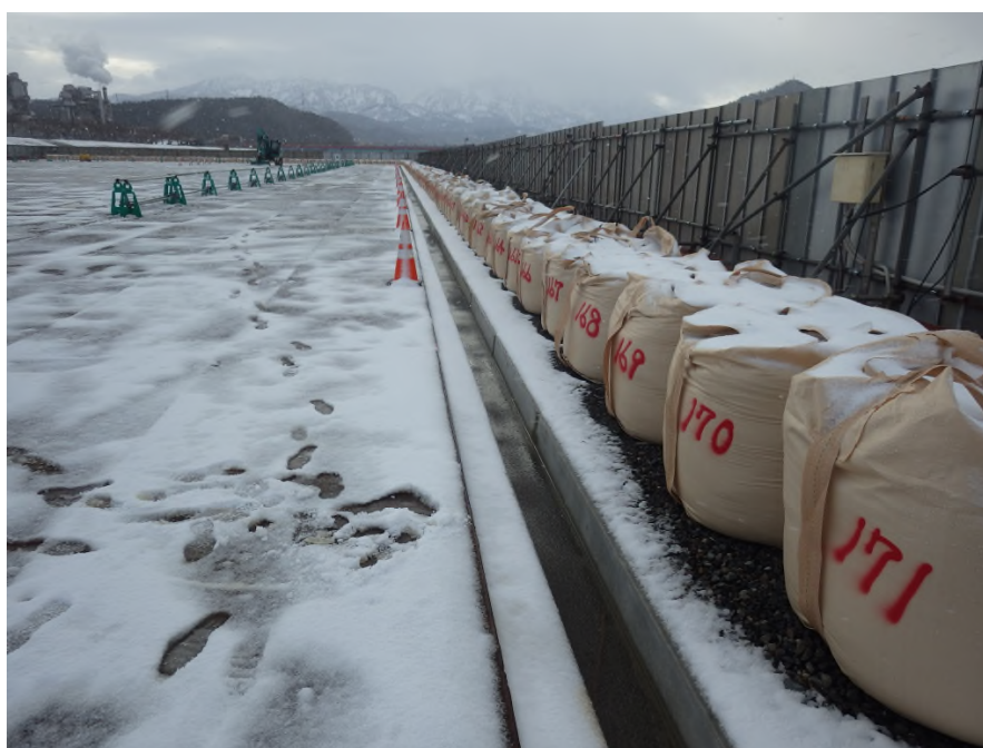
写真2-2-(3)-4 側溝及び土のう等の設置状況（開設後）
