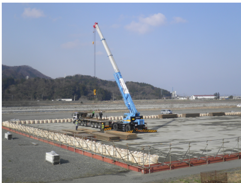
写真2-3-(4)-1 仮置場の原状復旧状況
