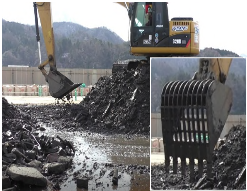
写真 2-3-(1)-2 スケルトンバケットによる選別
