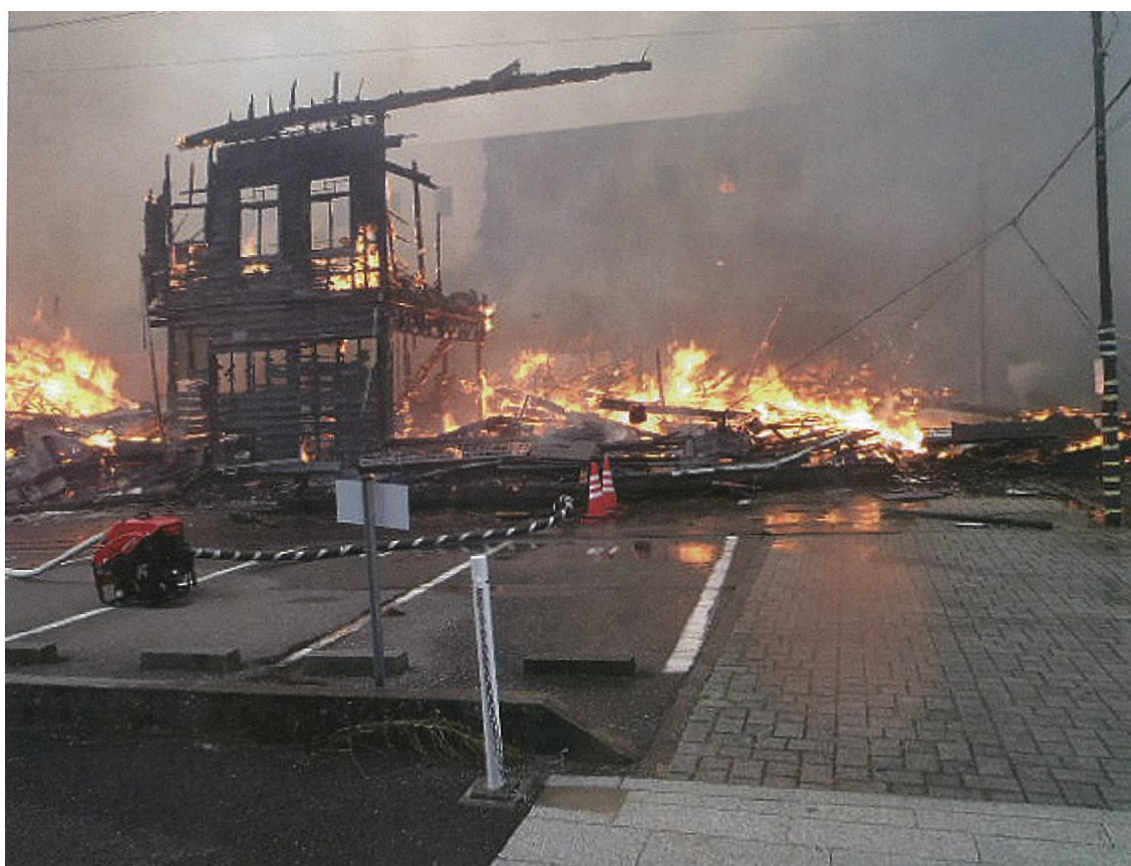
写真 1-1-(1)-2 被災状況（本町通り）
