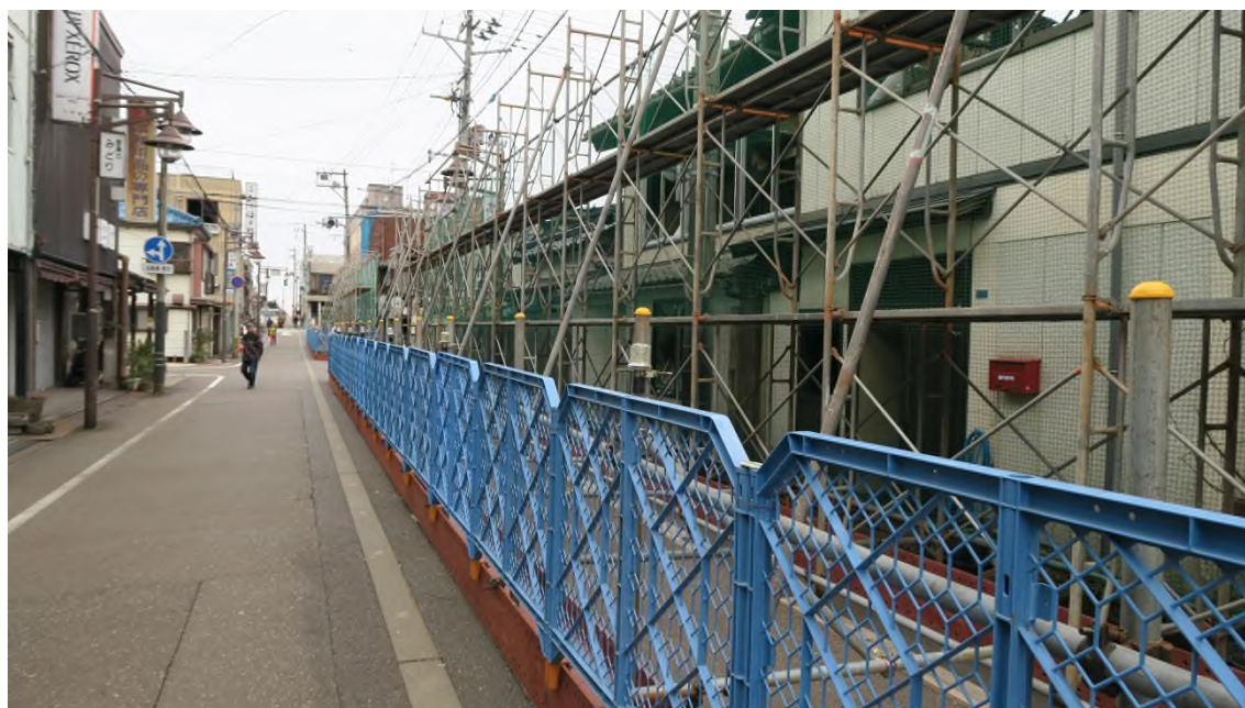
写真 4-1-(4)-1 建物倒壊対策状況（足場の組み立て及び立入防止柵の設置）
