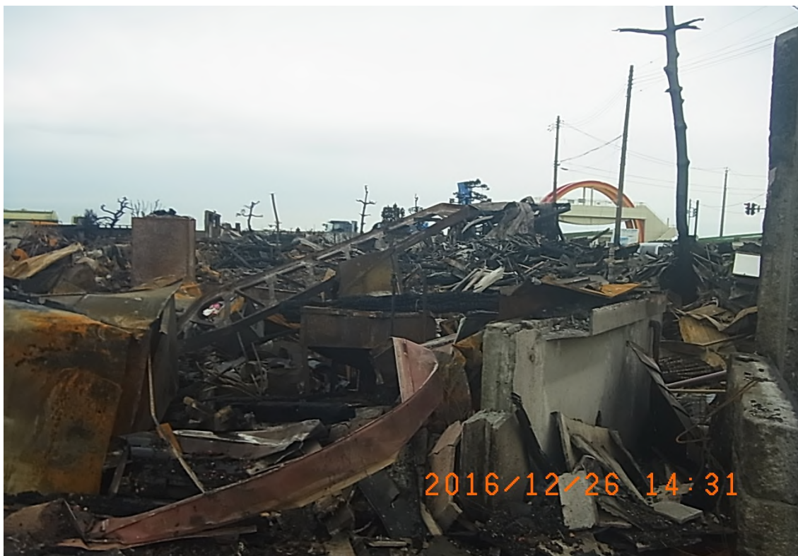
写真 1-1-(3)-1 1ブロックの被災状況
