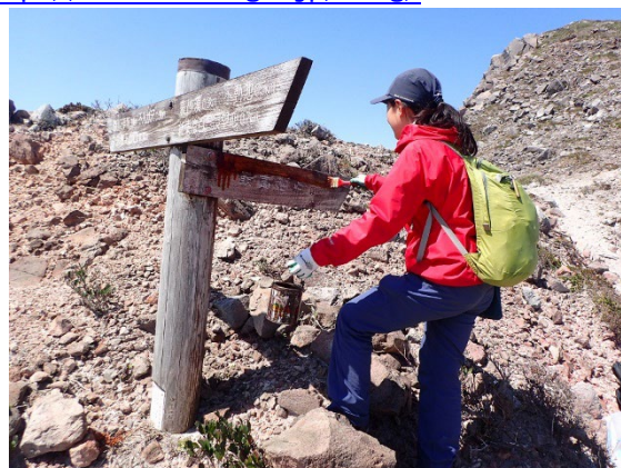
登山道看板の修繕（神津島）
