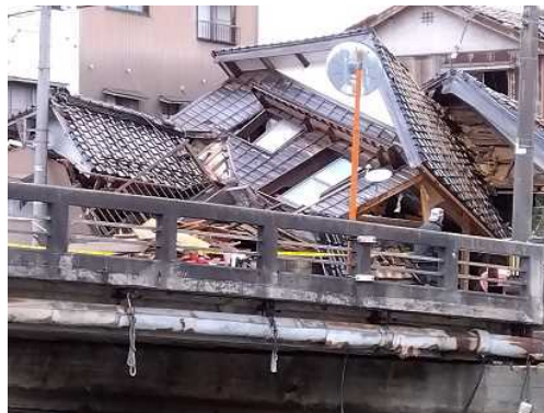
石川県穴水町 民家の被害 (1月5日)
