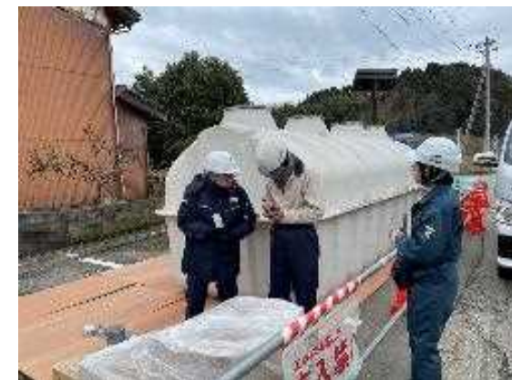
能登町での浄化槽の状況確認
