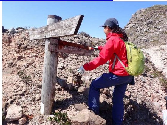
登山道看板の修繕（神津島）
