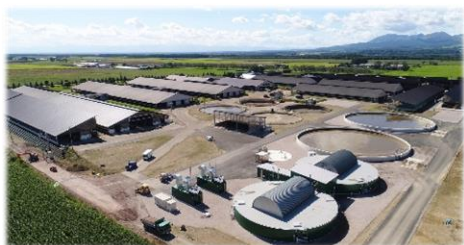
バイオガスプラント
