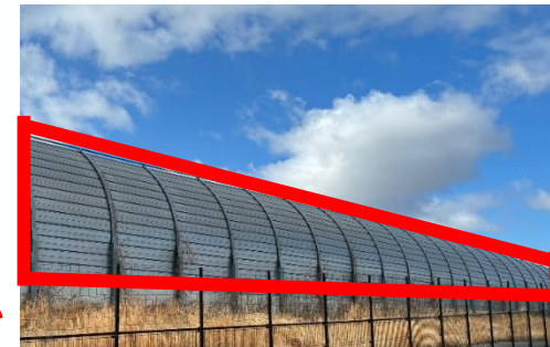
高速道路内の遮音壁（外壁）
