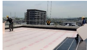
公共施設等のZEB化 (屋根の高断熱化・複層ガラスの導入)
