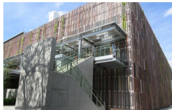
廃棄物焼却施設の外観
