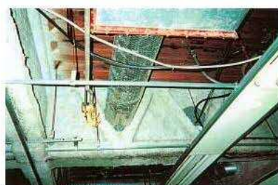
鉄骨造の梁・柱の耐火被覆
