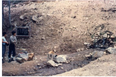
工事が中止になった道路（石清水付近）
