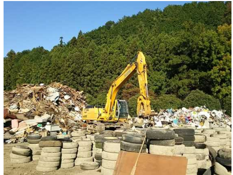
仮置場の状況(市撮影)
