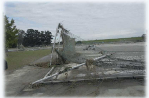
（市営公園での被害状況）
