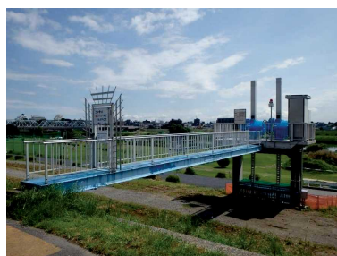
＜樋管全景写真＞
