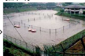
雨水貯留浸透施設の例(防災調整池)
