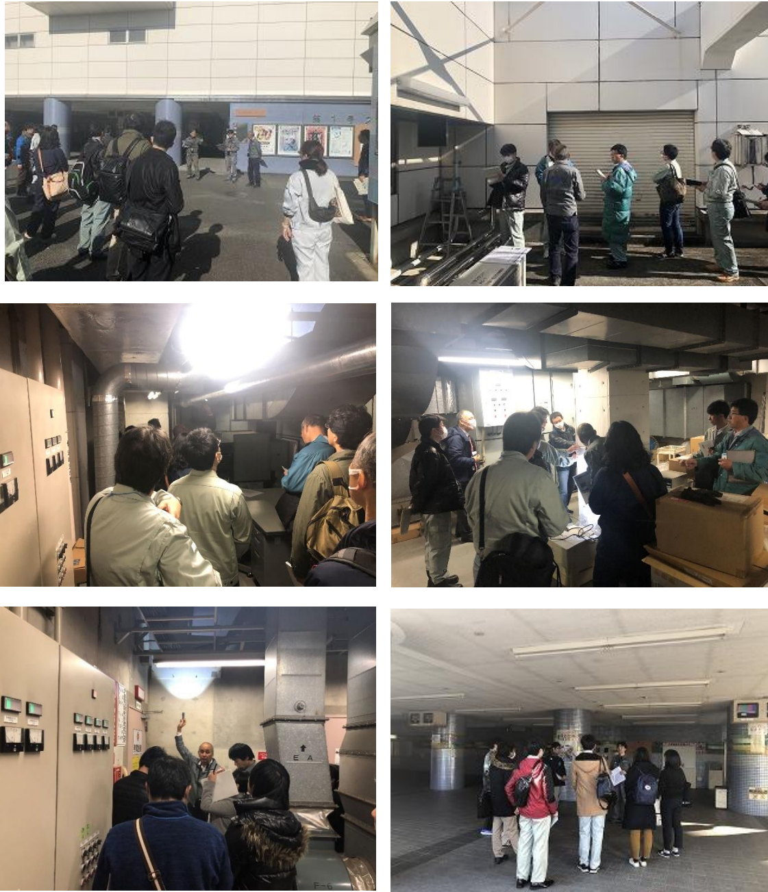
図4-1 災害時の建築物アスベスト調査について（現場見学）の状況
