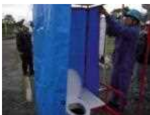
組立トイレの組立訓練
