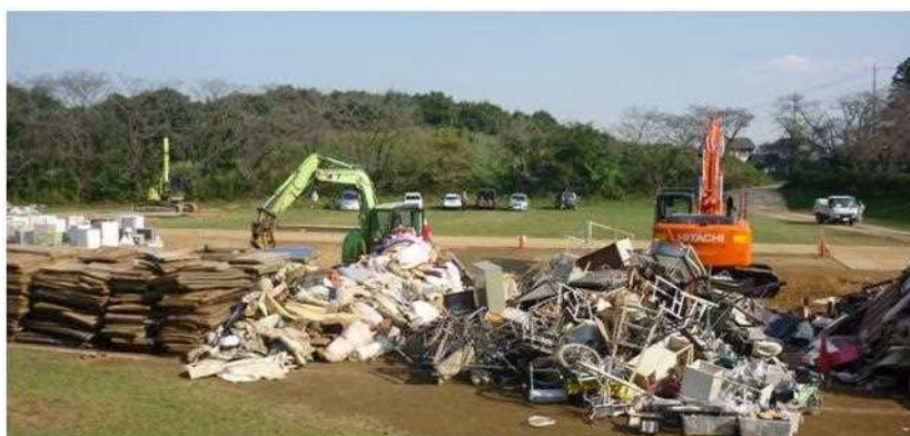
仮置場での分別の状況
