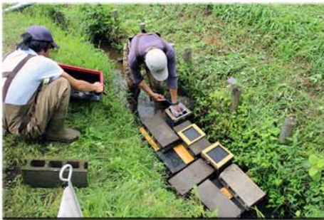
写真4 設置・導入作業
