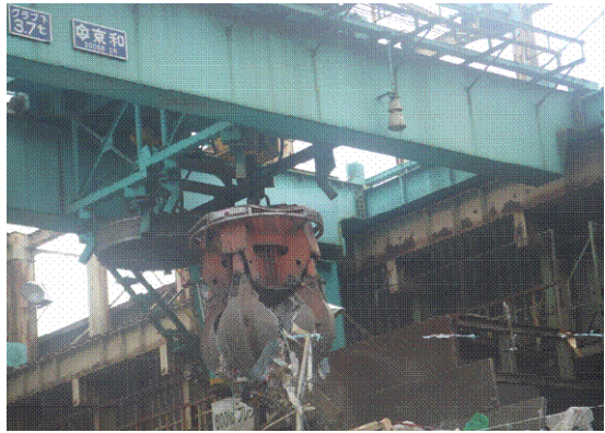
プレシュレッダーへの投入クレーン
