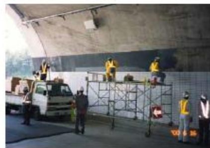
写真—3 リサイクル外装壁タイルのトンネル側壁施工状況
