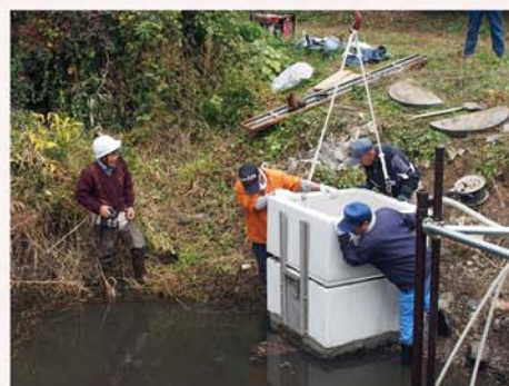
③ 設置作業
