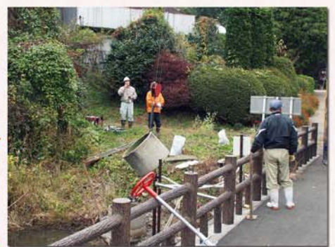
② 撤去作業
