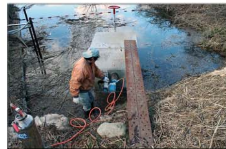
取水塔改修作業 ～ 生き物に優しい取水のあり方 step1 ～
