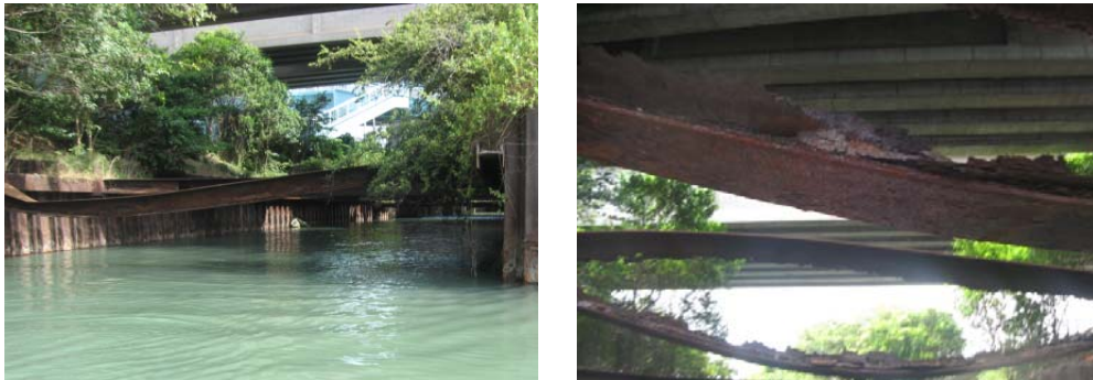
図 カルバート内の腐食した鉄筋
