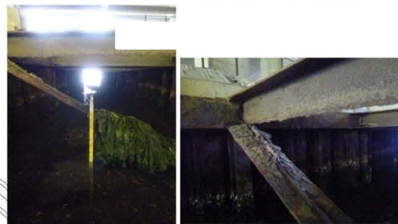
③暗きよ部切梁腐食による損傷(H型鋼)
