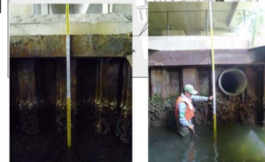
④腹起し～底面の高さ (排水口部)H=2.5m
